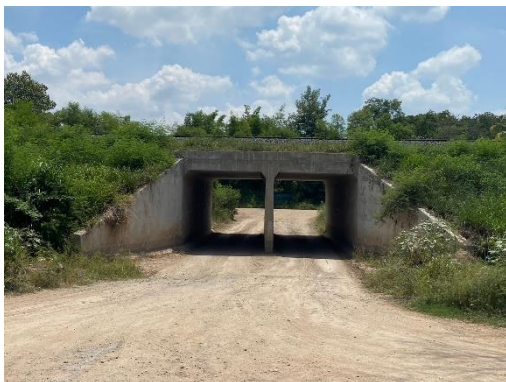
ท่อเหลี่ยมลอดใต้ทางรถไฟ (Box Culvert)
