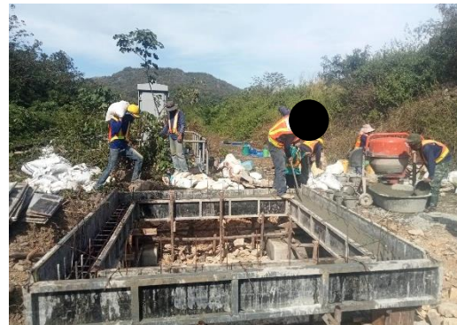
งานก่อสร้างฐานคอนกรีตสำหรับติดตั้งตู้ LOC ที่สถานีมาบะเปา
