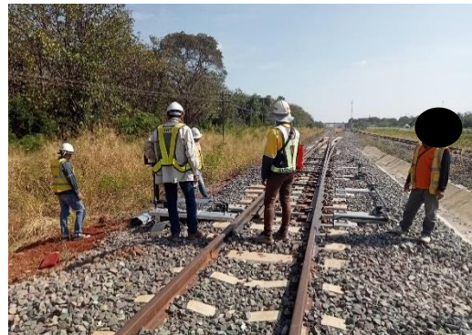
งานตรวจสอบการติดตั้ง Point Machine ที่สถานีปางอโศก
