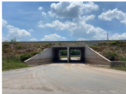
ท่อเหลี่ยมลอดใต้ทางรถไฟ (Box Culvert)
