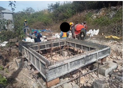
งานก่อสร้างฐานคอนกรีตสำหรับติดตั้งตู้ LOC ที่สถานีมาบะเปา
