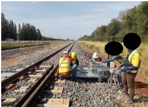
งานตรวจสอบการติดตั้ง Point Machine ที่สถานีปางอโศก
